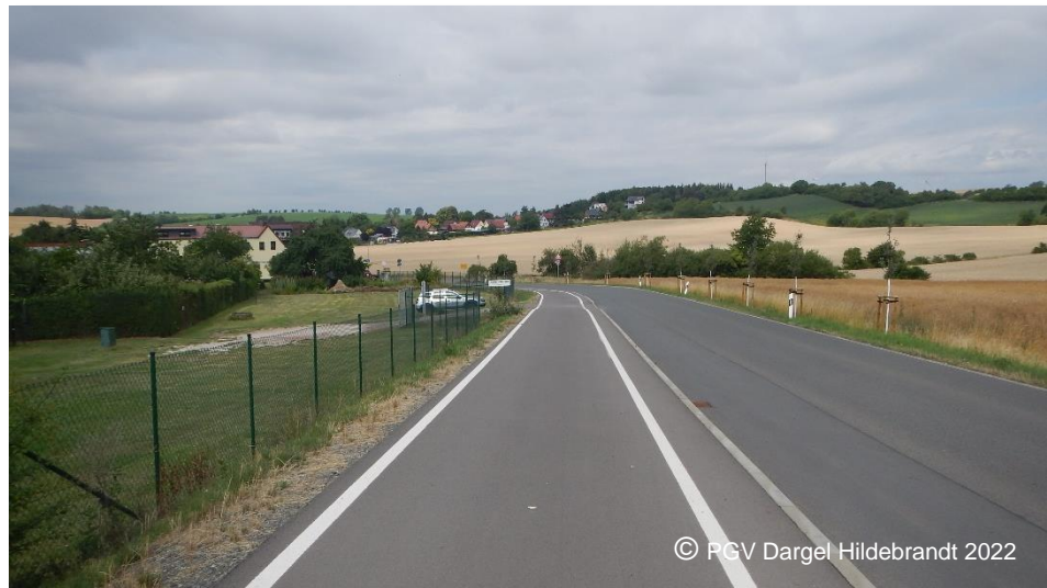
Abb. 16 K 20, Radwegeneubau an Kreisstraße (Nordhausen, PR10/11)
