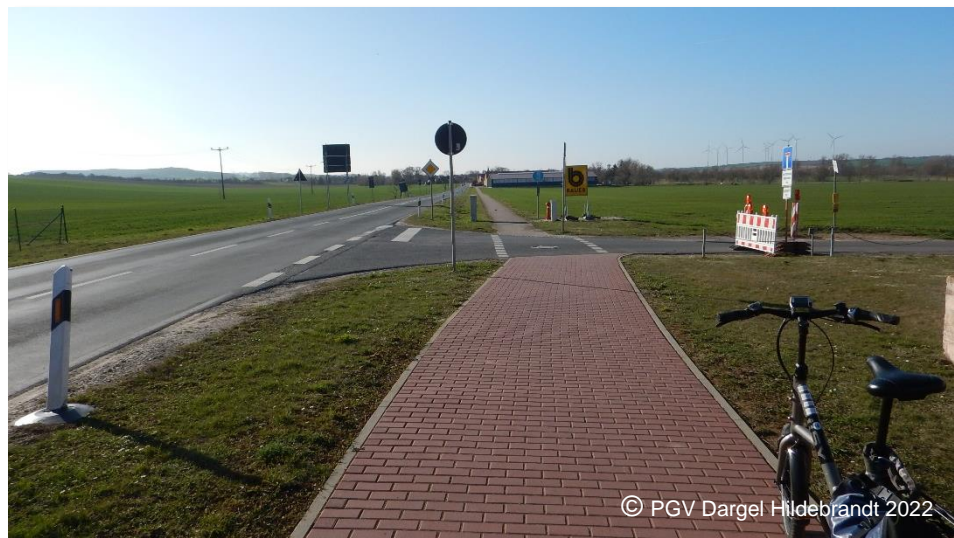
Abb. 12 L 1034, Radwegeneubau an Landesstraße (Bleicherode)
