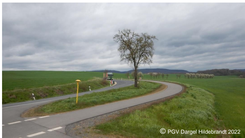
Abb. 11 L 1037, Radwegeneubau an Landesstraße (Harztor, PR1b)
