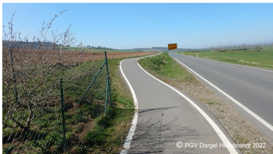
Abb. 15 K 27, Radwegeneubau an Kreisstraße (Heringen/Helme, PR5)
