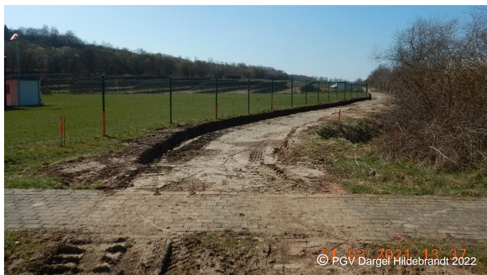
Abb. 13 L 1037, Radwegeneubau an Landesstraße (Zwischenstand Ellrich, PR1a)
