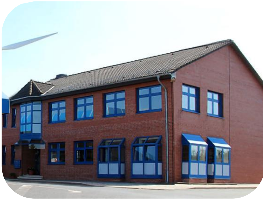
Abb. 73: Verwaltungsgebäude Kreisabfalldéponie Nentzelsrode ( abfall-nordhausen.de )
