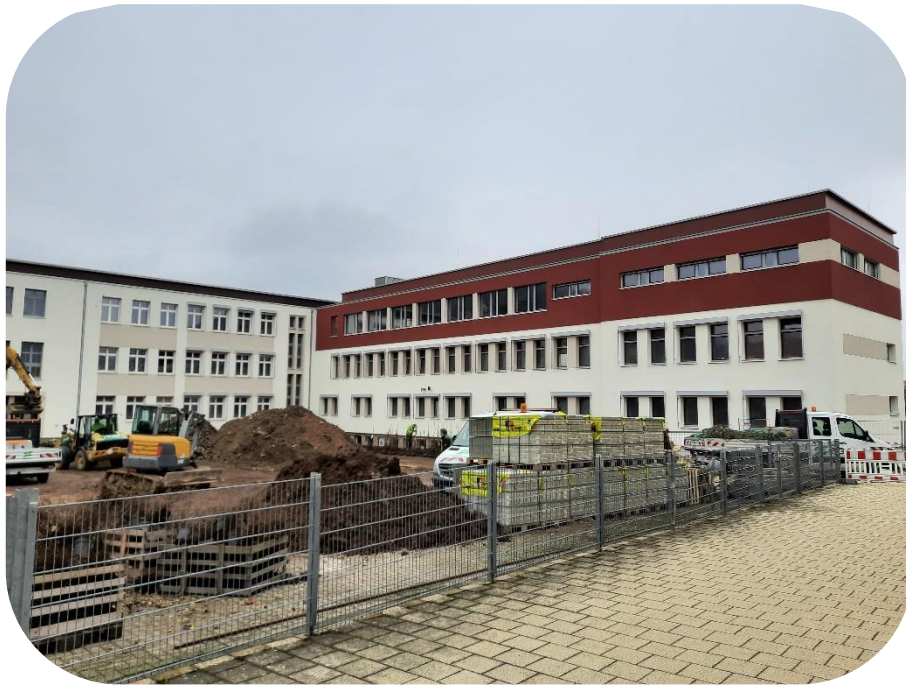
Abb. 23: Baumaßnahmen am Gymnasium, Bleicherode (Verwaltungsangabe, 2021/2022)
