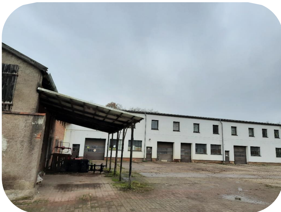
Abb. 72: Gebäude des Katastrophenschutzes am Schorfe 17 (eigene Fotografie)
