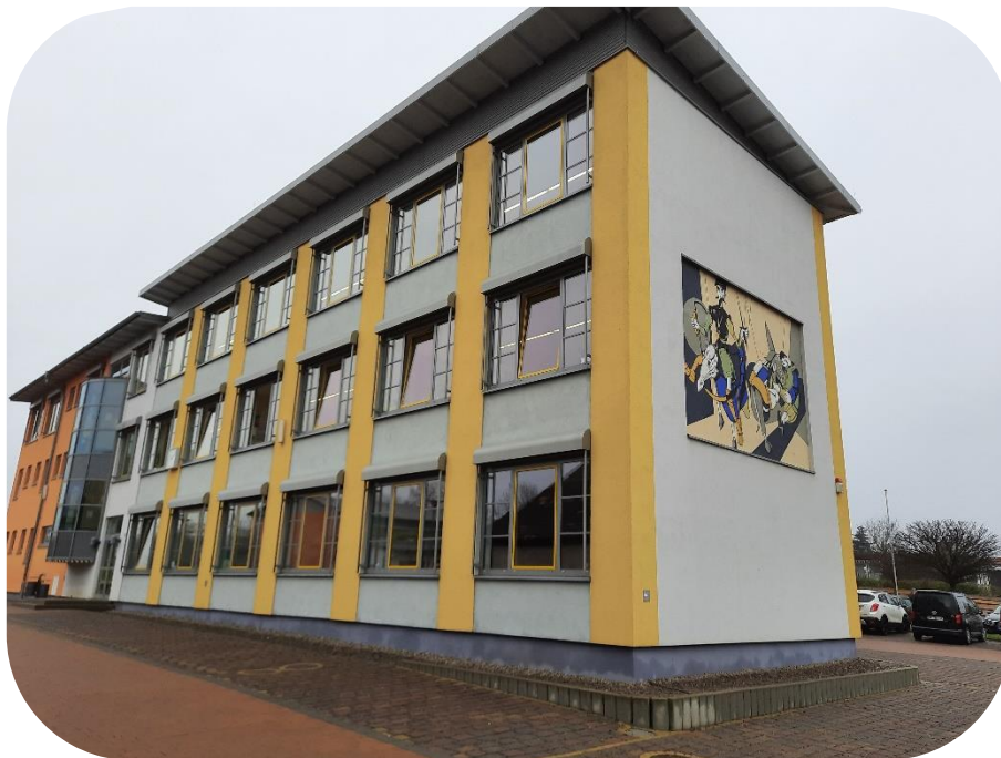
Abb. 46: Gebäude der staatl. Regelschule „Hainleite“ (eigene Fotografie)
