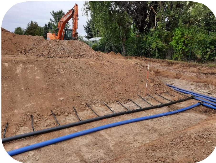
Abb. 33: Verlegung des Kollektorfeldes in Werther (eigene Fotografie)
