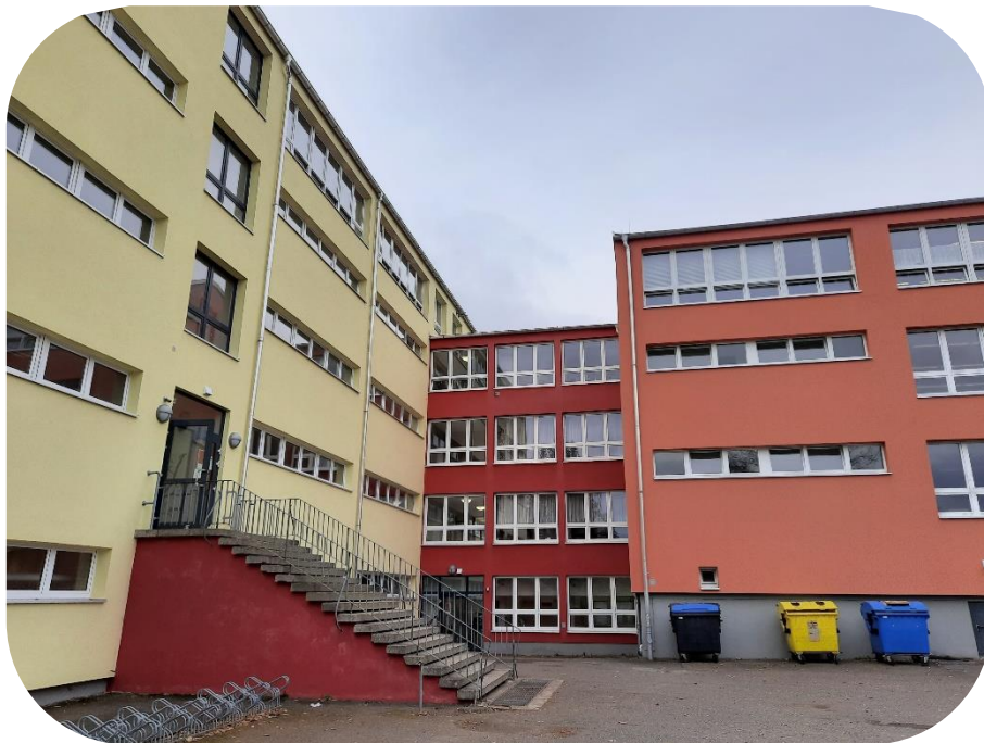
Abb. 45: Gebäude der RS „Löwentor“ in Bleicherode (eigene Fotografie)
