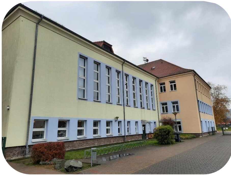
Abb. 64: Gebäude der staatl. Regelschule Heringen (eigene Fotografie)
