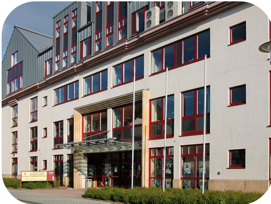
Abb. 69: Gebäude der Behringstraße 3 in Nordhausen (eigene Fotografie)
