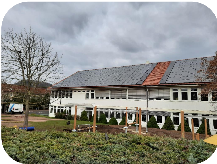
Abb. 44: Gebäude der GS in Bleicherode (eigene Fotografie)
